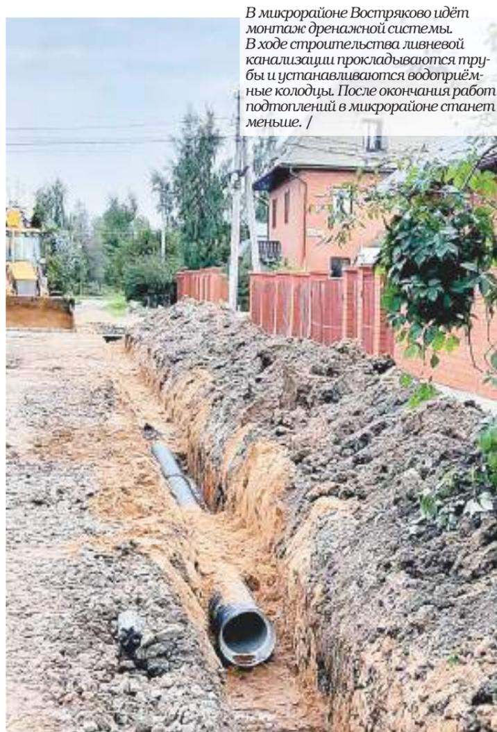
В микрорайоне Востряково идёт монтаж дренажной системы. В ходе строительства ливневой канализации прокладываются трубы и устанавливаются водоприёмные колодцы. После окончания работ подтоплений в микрорайоне станет меньше. /
