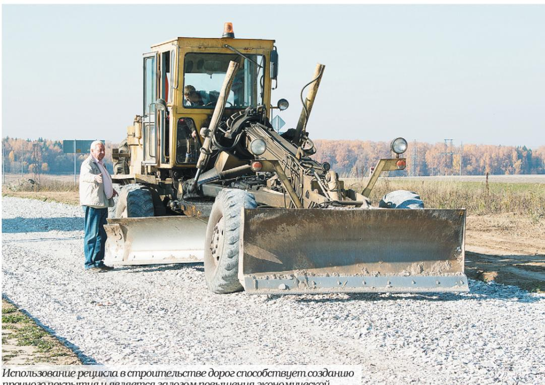
Использование рецикла в строительстве дорог способствует созданию прочного покрытия и является залогом повышения экономической эффективности процесса строительства, так как рецикл – продукт вторичной переработки сырья. Этот материал для ремонта дорог использует и компания «Эластик».
